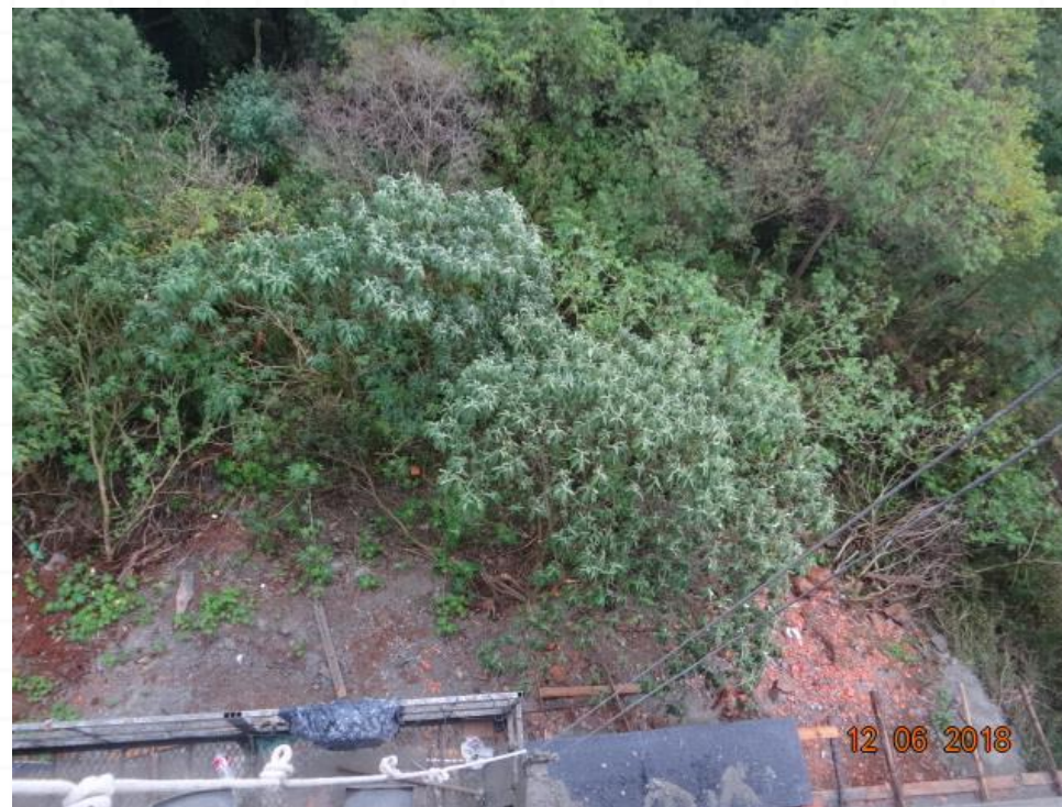
ETE em área de preservação Terreno extremamente inclinado Havia rede de esgoto
